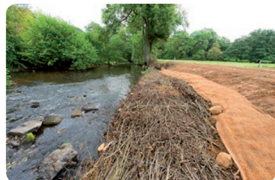
La rivière « La Rouvre » après travaux de restauration.
