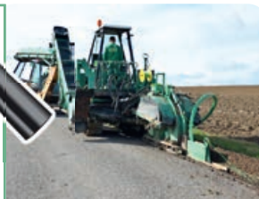
Travaux portant sur la pose de fibre optique
