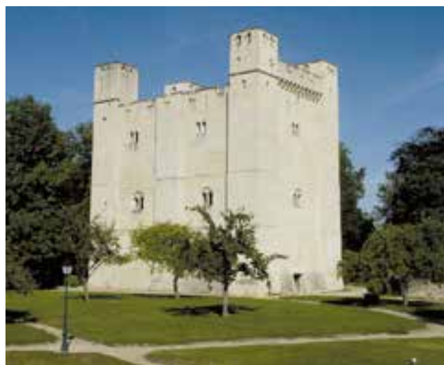
5 LE DONJON DE CHAMBOIS, XII e S. L'imposante tour, dans un état de conservation remarquable, était entourée d'un complexe castral qui a disparu. Cette fortification de plaine ne disposait d'aucune défense naturelle. L'édifice est propriété du Département.
