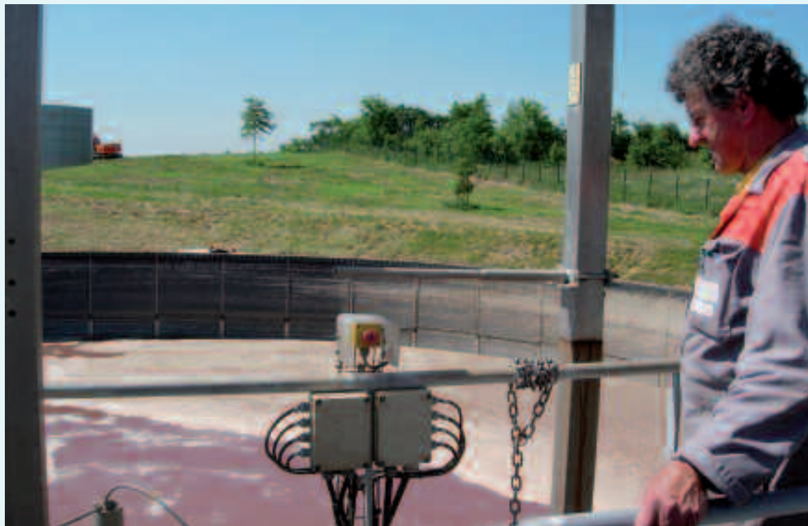
Hubert Bansard, responsable de la station d'épuration de la Société Normande de Volailles à La Chapelle d'Andaine.
