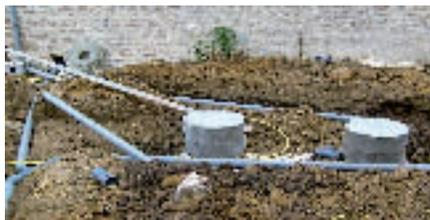
L'écoulement des eaux pluviales doit être bien séparé des canalisations d'eaux usées. La fosse et les regards du système d'assainissement doivent rester accessibles pour l'entretien (vidange, nettoyage...) et les contrôles. Les angles des canalisations sont limités à 45° pour éviter les bouchons.
