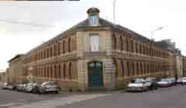
1907 : la Société générale des tissages de Flers regroupe quatre usines. Bureaux et entrepôts occupaient un vaste espace au centre ville.
