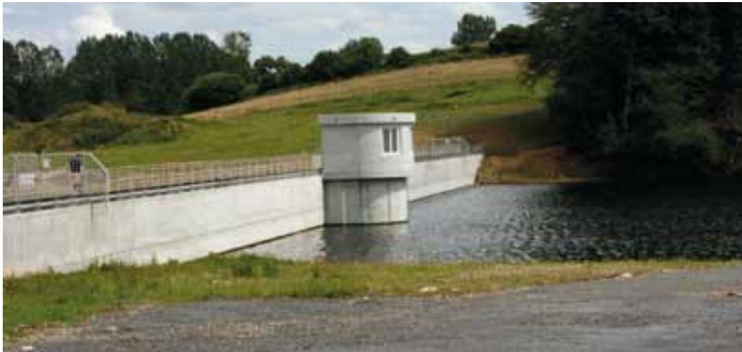
Long de 190 mètres, le nouveau barrage va permettre d'élever de 65 cm le niveau de la retenue d'eau. Celle-ci alimente la station du centre de Flers par un système de jeu de vannes activées depuis la tour de prise, au centre de l'ouvrage.
