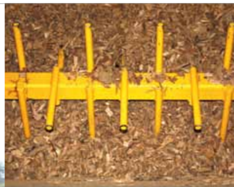
Silo à fond mouvant qui dirige sans intervention humaine le bois déchiqueté vers la chaudière.
