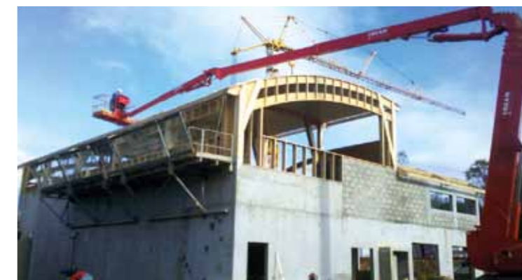
Intégrée au site (bardage bois) et aux normes HQE, l'usine offrira une eau de bonne qualité bactériologique.
