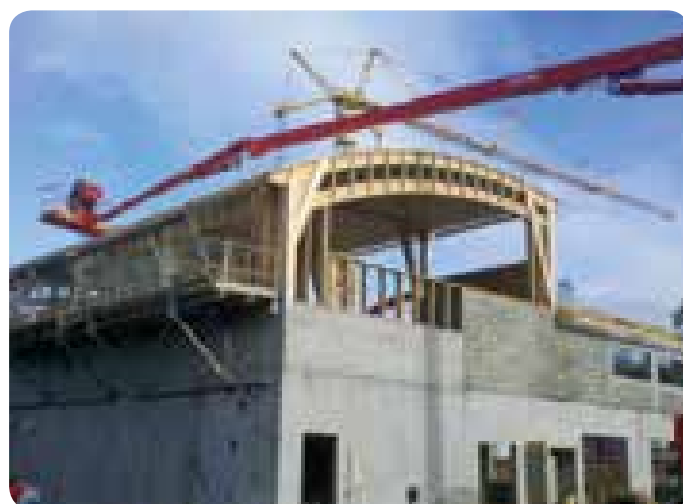
➤ Un important chantier d'alimentation en eau potable a été conduit avec le SIAEP du Houleme avec la construction de cette usine d'eau potable à Saint-Hilaire-de-Briouze.
