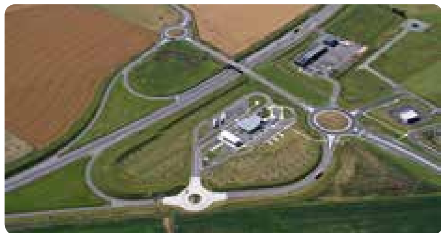
➤ La modernisation de l'axe routier structurant Flers-Argentan (RD924) s'est poursuivie. Ici, la section est à Sevrai le 24 juillet 2012.
