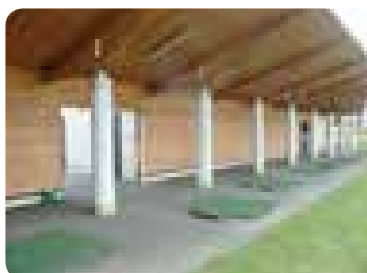
➤ Construction du practice.
