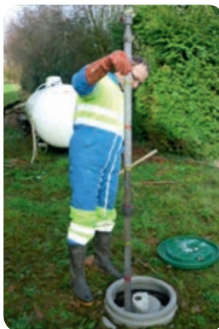
↳ Mesure de la hauteur des boues
