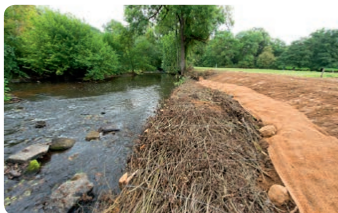
↳ La rivière « la Rouvre » après travaux de restauration.
