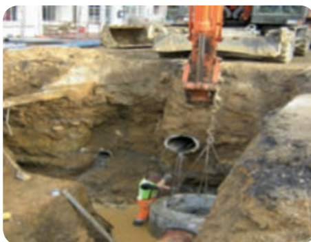
➤ Bagnoles-de-l'Orme. Réhabilitation du réseau d'eaux usées et d'eaux pluviales
