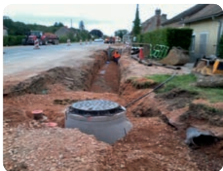
➤ Travaux d'assainissement collectif à Sully-en-Gouffern. 98 habitations raccordées
