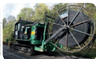
Pose de fourreaux
