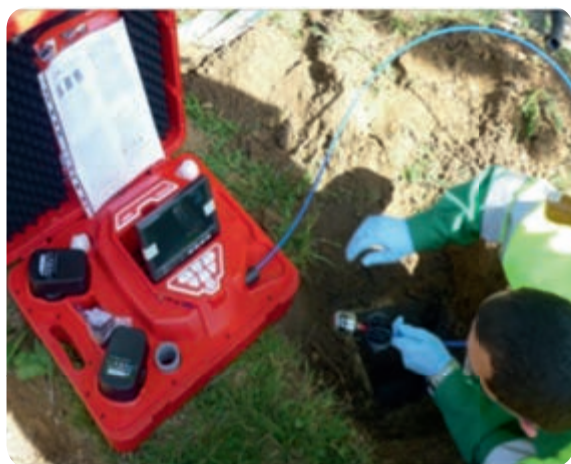
↳ Inspection caméra d'un système d'assainissement non collectif
