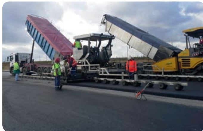
Travaux de chaussées RD 924 Sevrai - A 88
