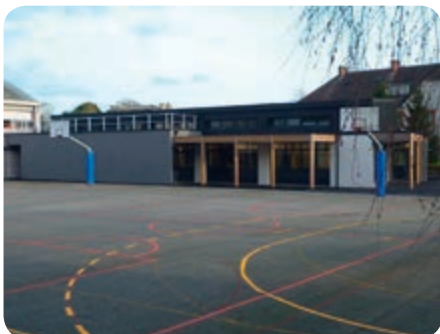
Le Mêle-sur-Sarthe - Façades cour avec terrain de sport
