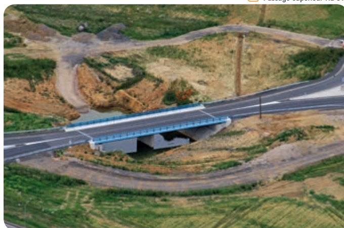
➤ Passage supérieur RD 916
