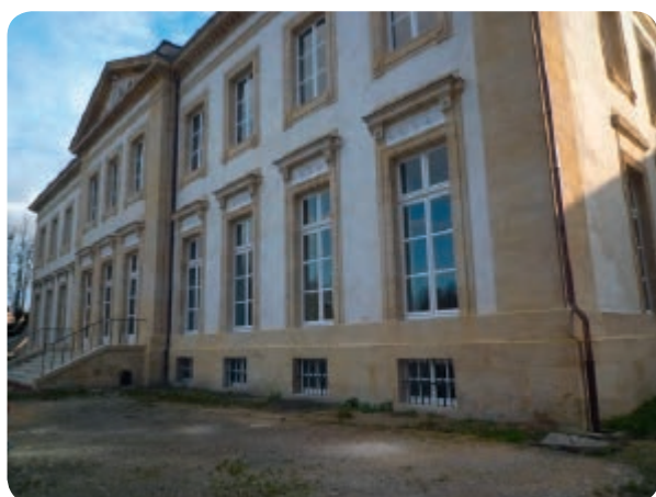
► Palais d'Argentré, façade nord
