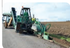
Travaux portant sur la pose de fibre optique
