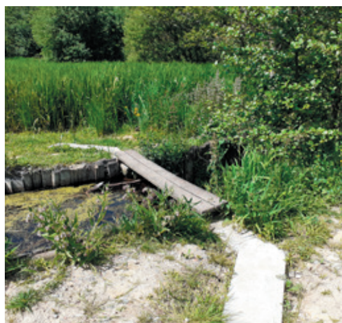
▲ Seuil hydraulique © CD61
