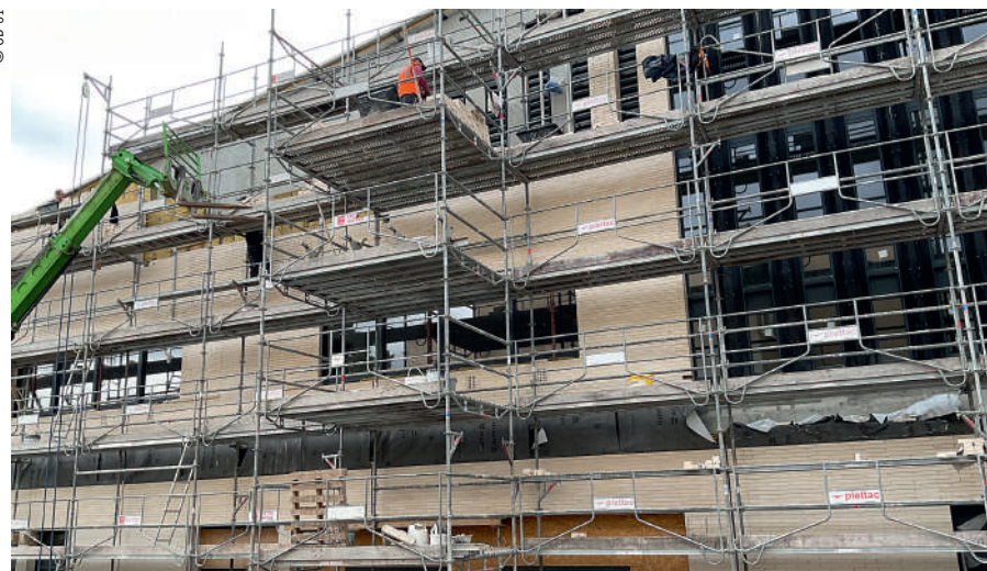
Pilotée par le Département, la reconstruction du collège Racine, à Alençon, a intégré près de 2 500 heures de travail en insertion.
