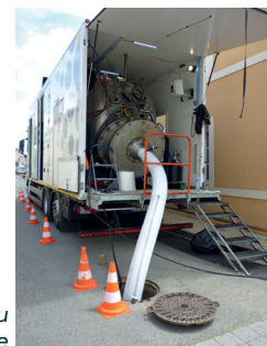
Réhabilitation de réseau par chemisage
